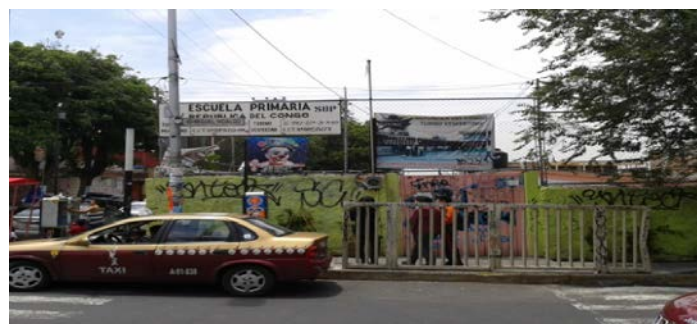
Fachada de la escuela en Avenida Hidalgo
