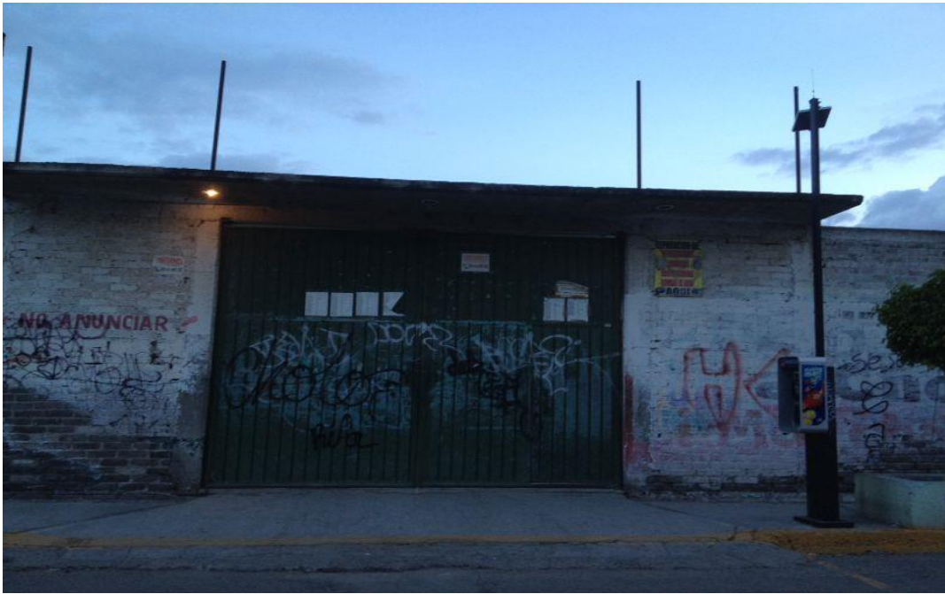
Fachada de la Escuela Secundaria "Francisco Villa"
