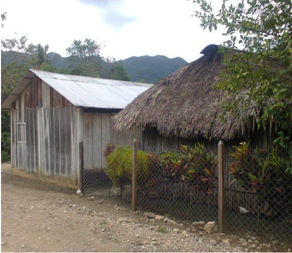
Casa con techo tipo “toro” y la cocina
