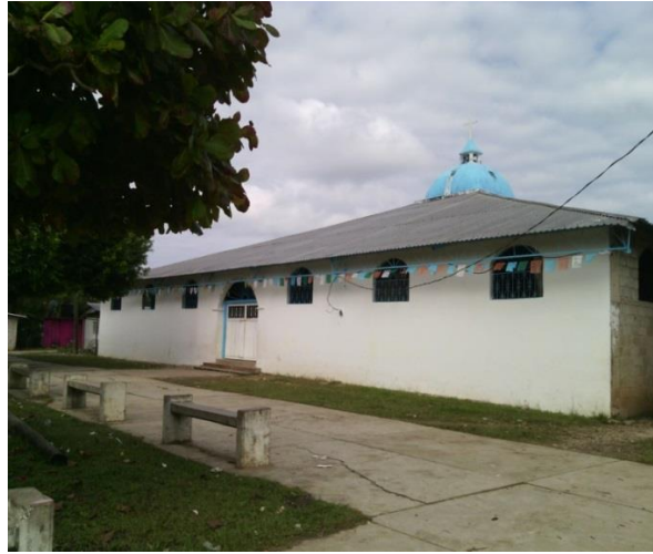
La fachada de la iglesia
