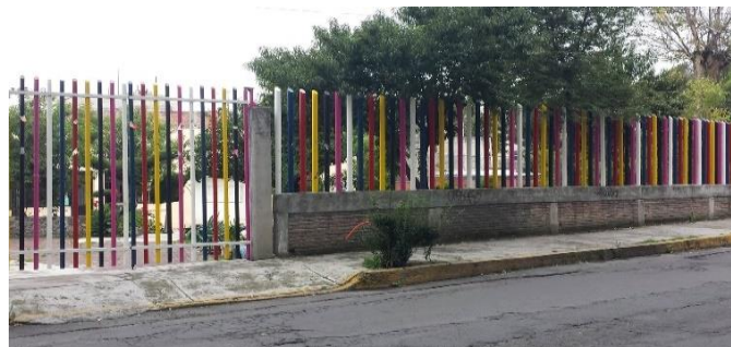
Foto No. 1. Vista exterior del Centro de Desarrollo Social “San Lucas” Fuente propia.
