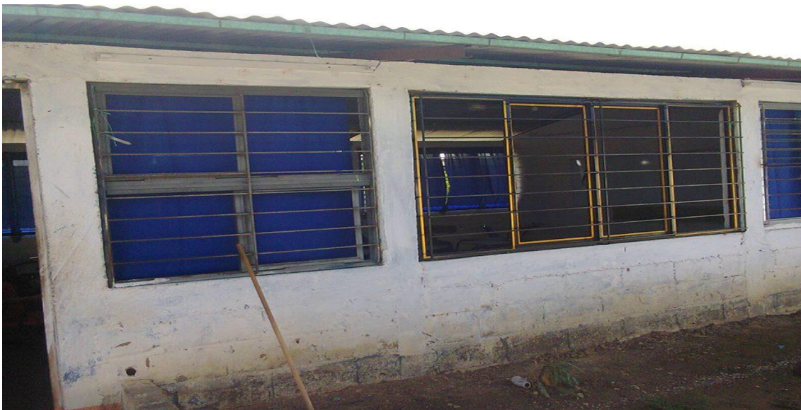
Salones construidos por padres de familia, con material de lámina y triplay.
