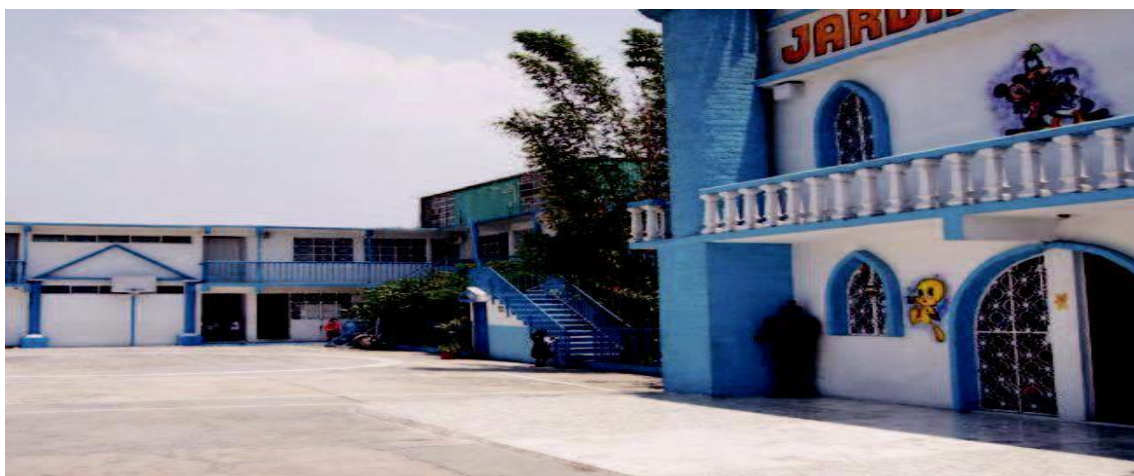
Imagen interior de la instalación
