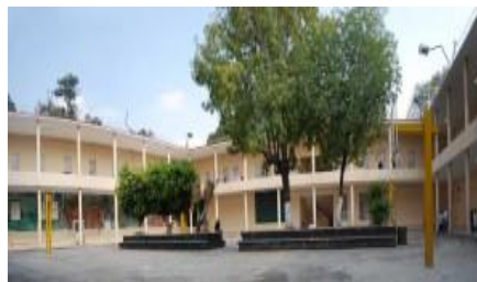
CTEA Interior (Patio 1) 34
