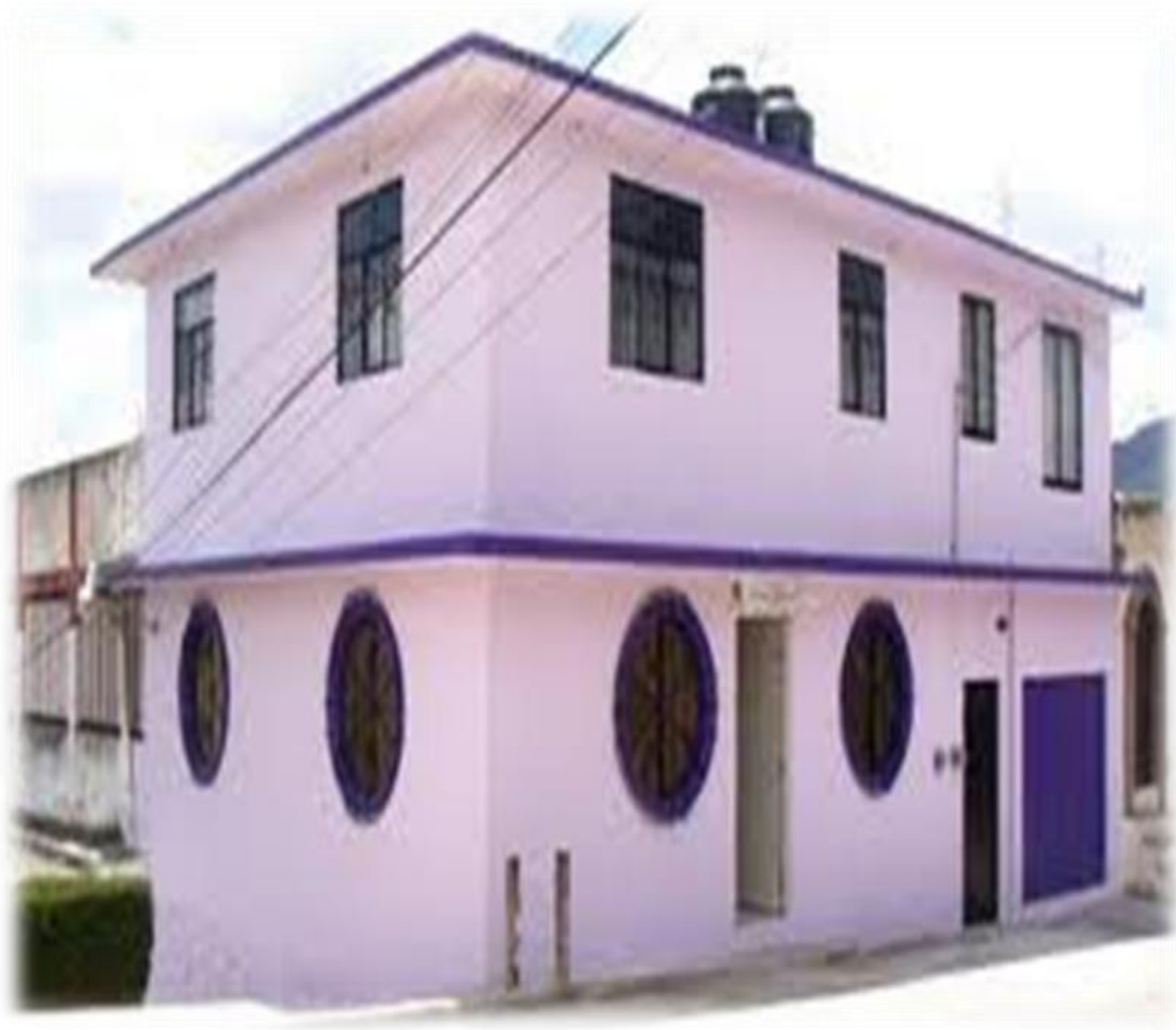
Casa de material: cemento, tabiques y techo de concreto.
