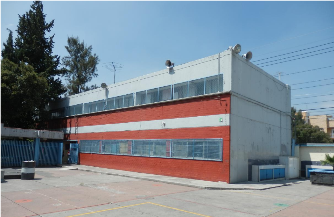
Foto: Edificio, en el cual se encuentra ubicada la biblioteca escolar, audiovisual y oficinas.
