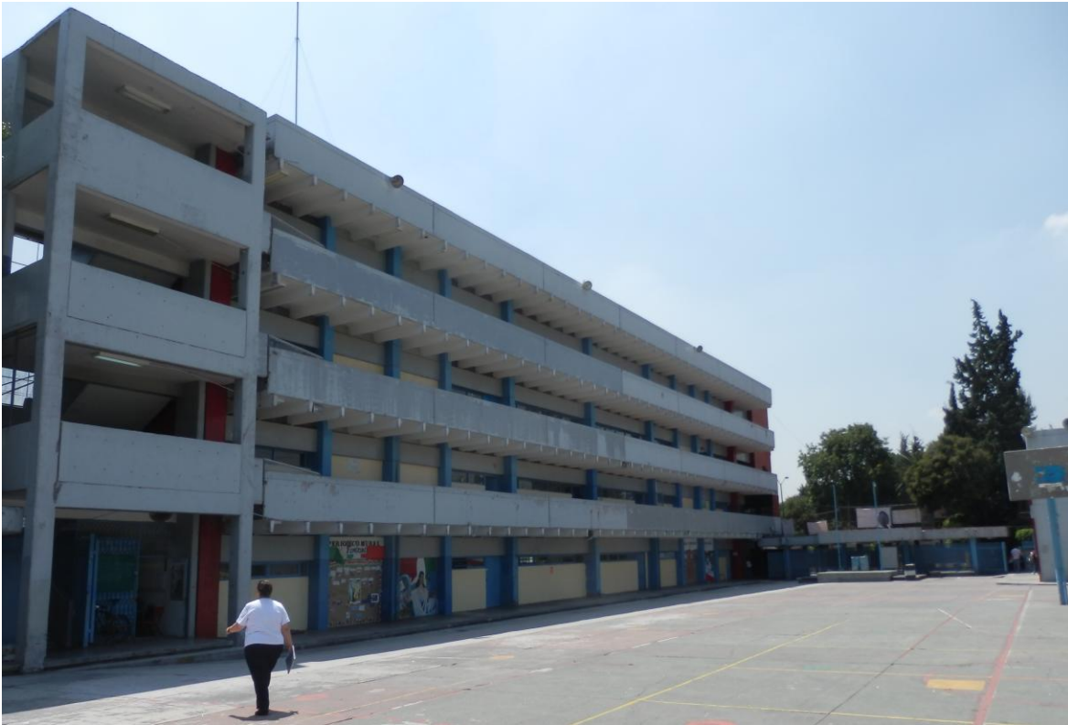
Foto: Edificio, lado Sur, de la Escuela Secundaria Número 164, Rumanía
