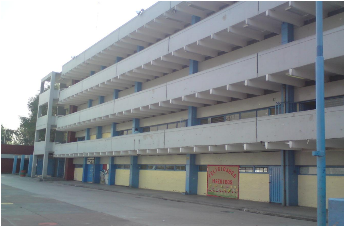
Foto: Se observan en el edificio, talleres en planta baja y salones distribuidos en los tres niveles.
