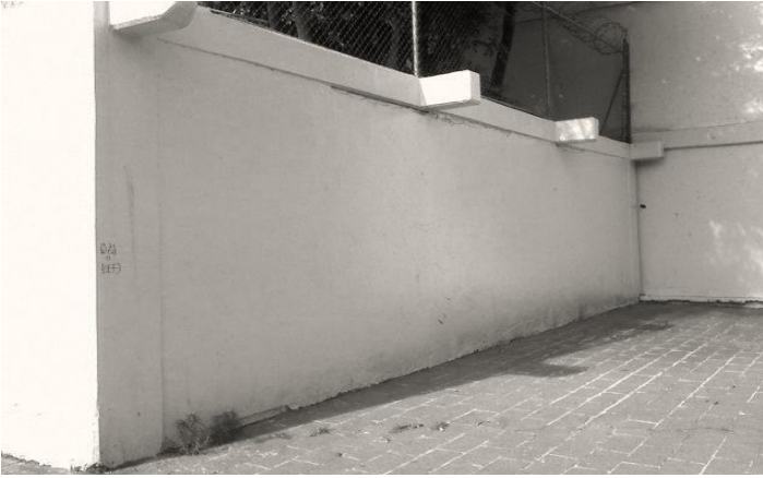
Ilustración 16. Muro exterior de la Escuela Secundaria Diurna 102 "Pedro Díaz"
