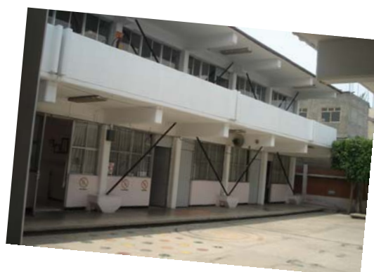
Aquí encontramos a la Dirección, Área Técnica, Trabajo Social, y en la parte de arriba se ven los salones de M – II, M – III y P – I.
