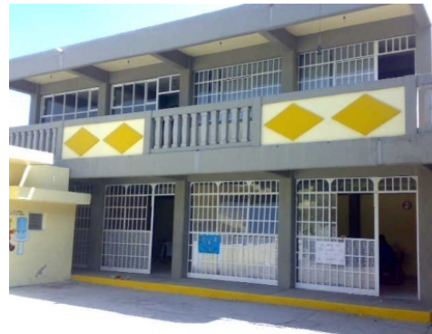
Instalaciones de Secundaria
