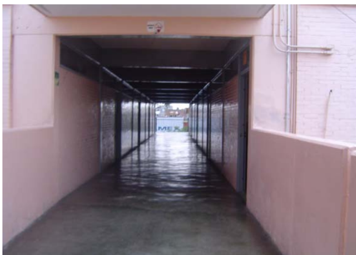
FOTO 3.- PASILLO DE LOS SALONES, PRIMER PISO
