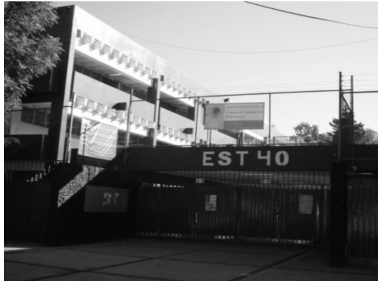
Fig. 3 Fachada EST. N° 40
