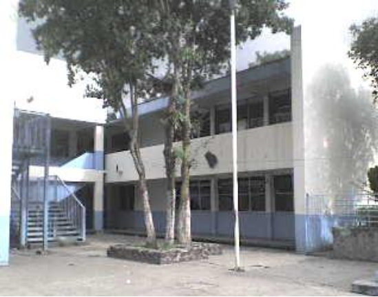
1.- Infraestructura de la escuela
