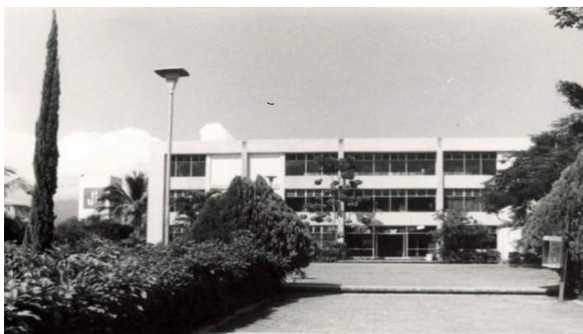
Imagen de las primeras instalaciones de la UPN localizada en la calle de Manuel Salazar número 201, ex hacienda del Rosario, Azcapotzalco. En unos edificios que originalmente se planearon para una unidad de la UAM y que hoy día es la Escuela Normal Superior.
