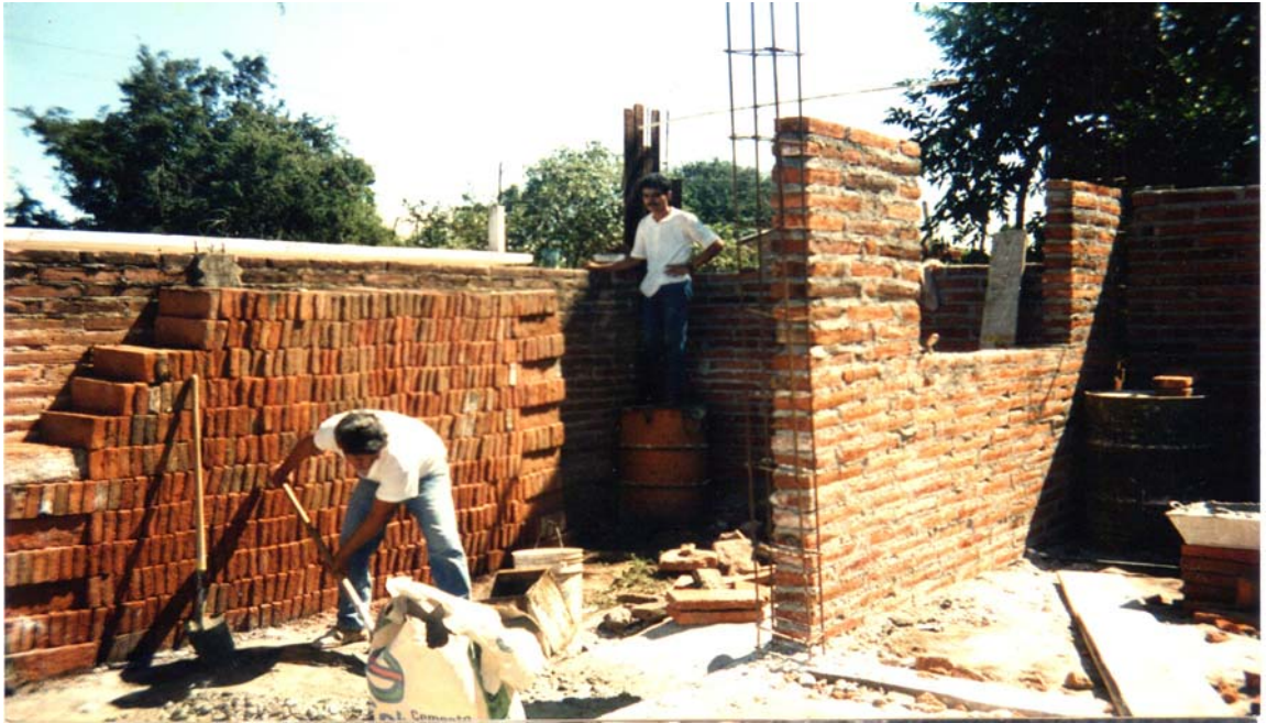
Construcción de una casa en la comunidad
