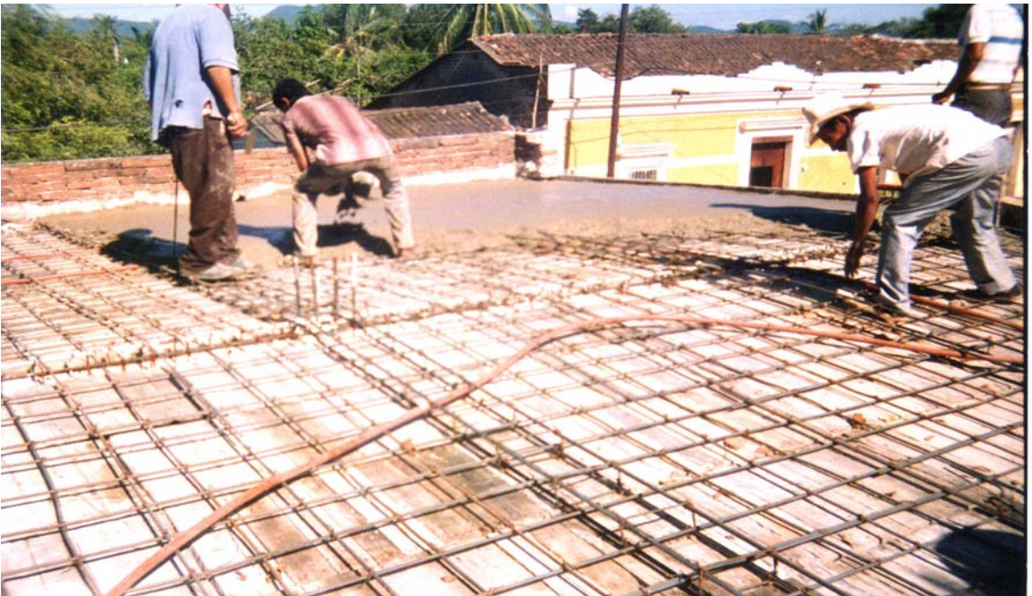
Colado de un vaciado en el techo
