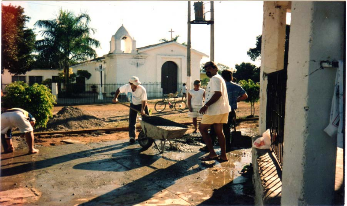
Construcción de banquetas
