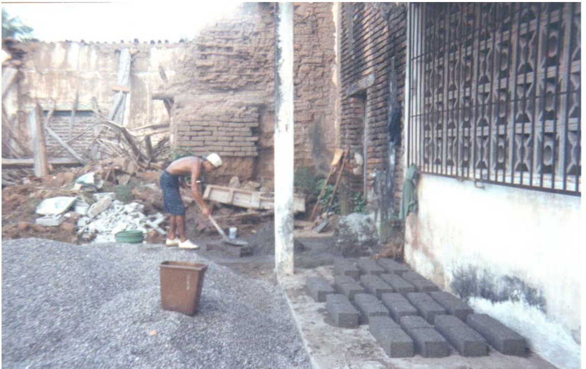
Elaboración de bloques de cemento por alumnos de la misión
