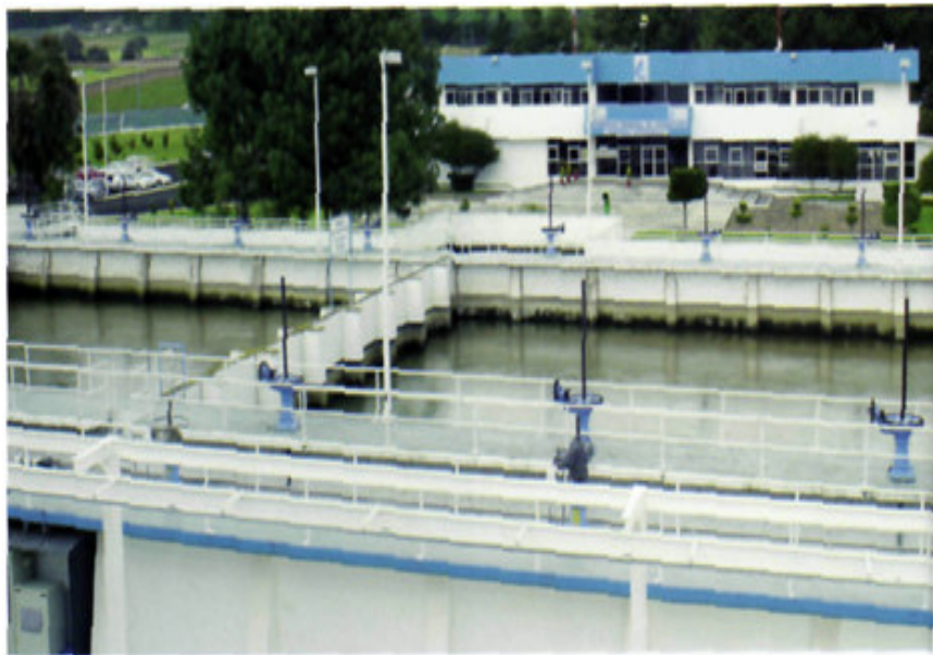
Planta potabilizadora Cutzamala, Estado de México
