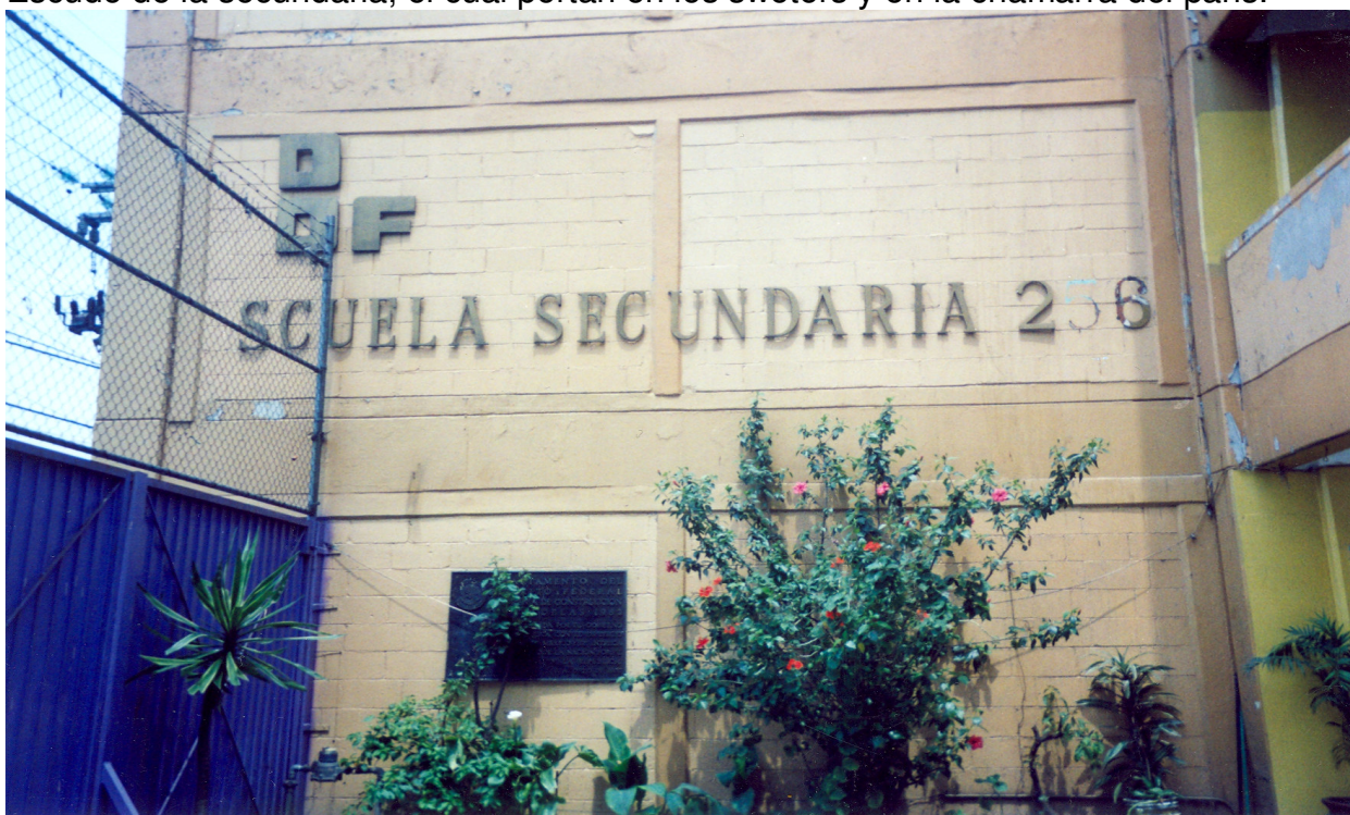
Esta es la puerta de entrada para los alumnos (as), asimismo se observa el deterioro del edificio.
