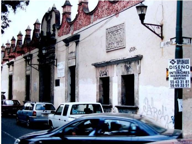
Foto No. 1 Aspecto exterior de la escuela secundaria
