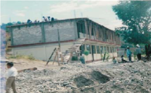
Inicio de la construcción del CBTa 131-01
