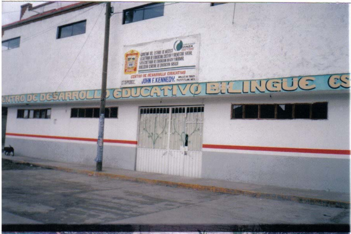
Fotografía 1. Vista del colegio.
