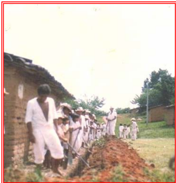
Faena realizada de los ciudadanos para meter el agua potable en la comunidad de Guadalupe Vict. Gro. Fotografía de Genoveva Santiago, abril 2005.
