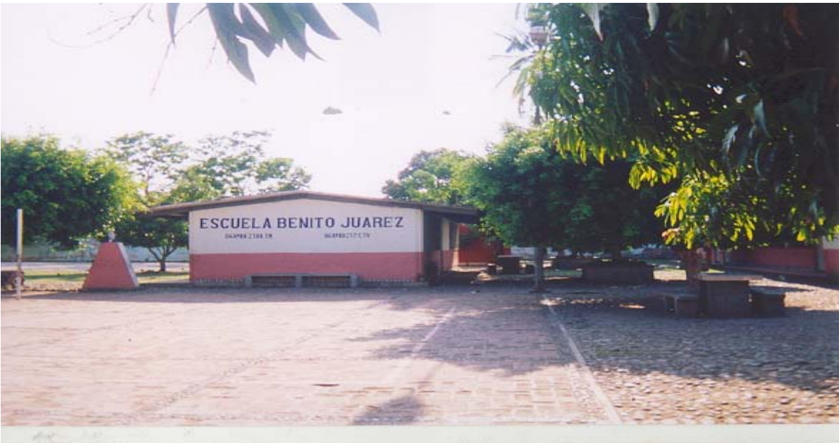
Interior de la escuela primaria: aulas intermedias y de fondo la cancha de Básquet y Fut-Bol.
