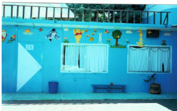
ANEXO 2. Fachada del salón de segundo de preescolar.
