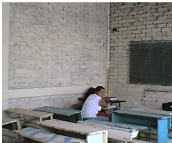
Interior del aula.
