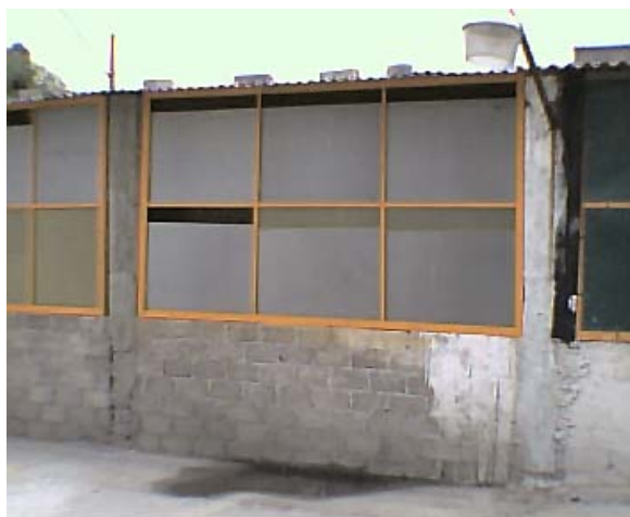
Exterior de un aula terminada.
