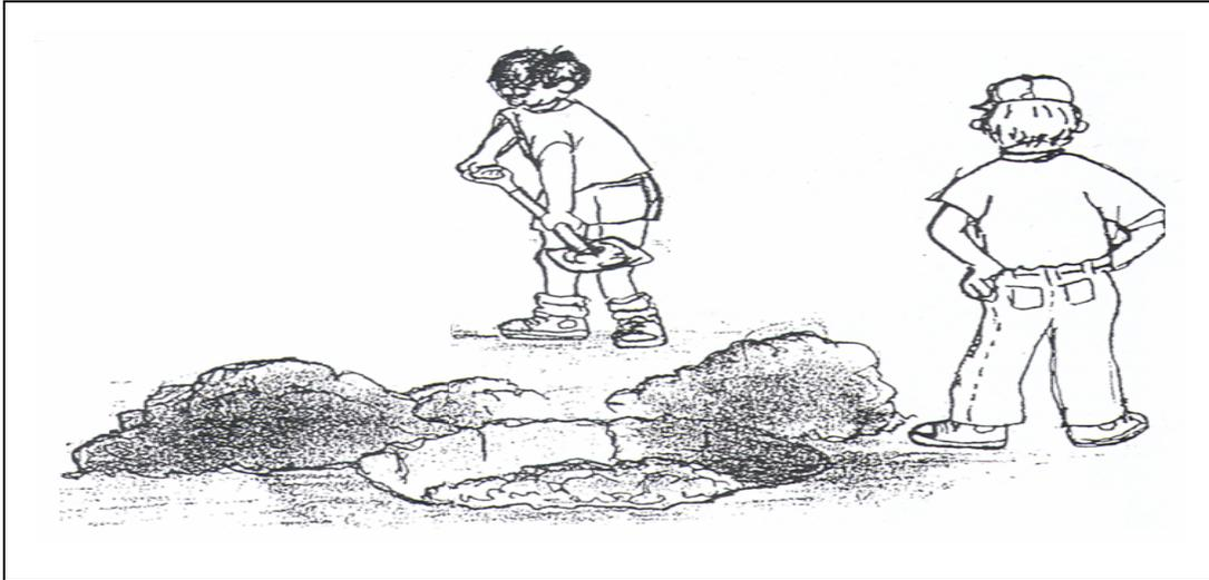
**En el centro de la trinchera, construir huecos en forma de prismas rectangulares para que sirvan como canales de ventilación.
