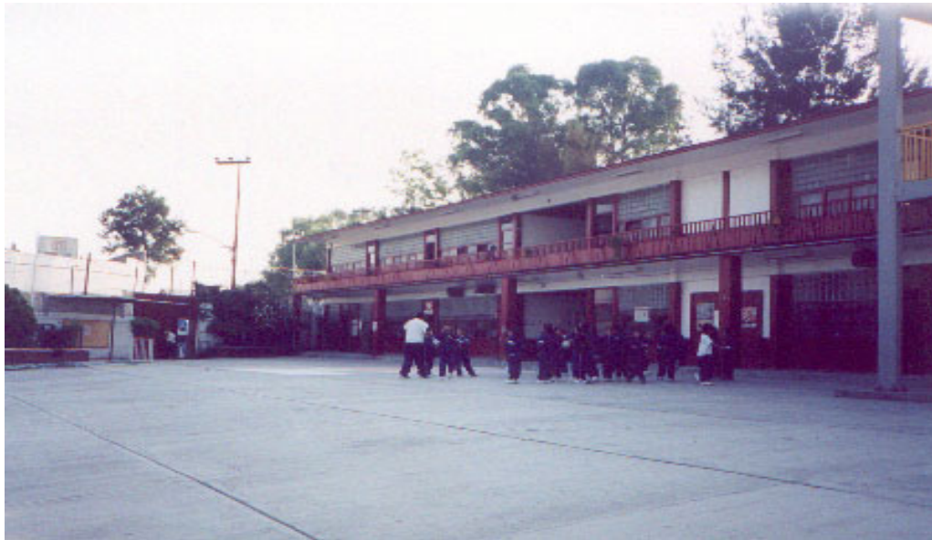
Foto 7. Vista interior de la escuela "Estado de Morelos"
