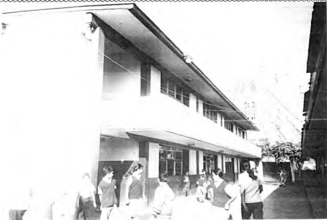
PARTE INTERIOR DEL EDIFICIO ESCOLAR: ESC.PRIM. URB.FED. " NIÑOS HÉROES ", SAHUAYO, MICH.
