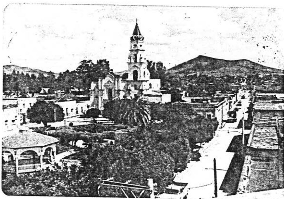
Panorámica del templo y del jardín principal antes de su remodelación.
