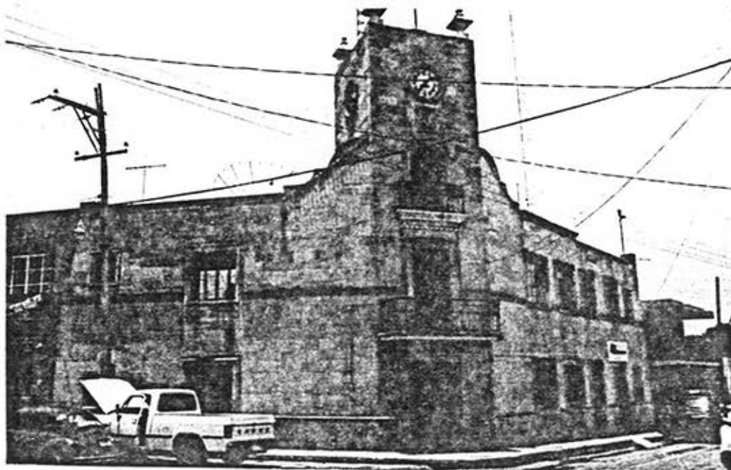
Presidencia municipal de El Arenal, construída en 1945.
