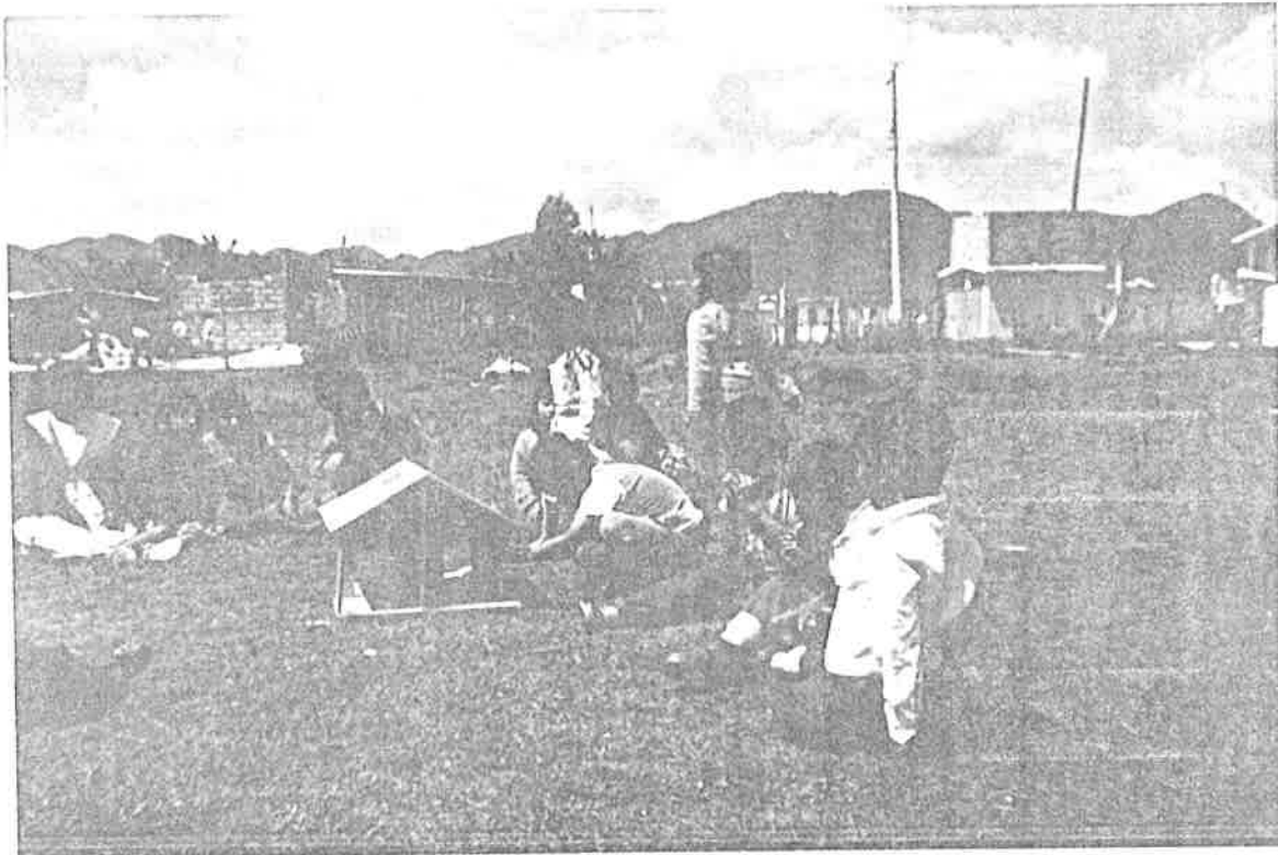
JUGANDO EN LA CONSTRUCCION DE UNA CASA.
