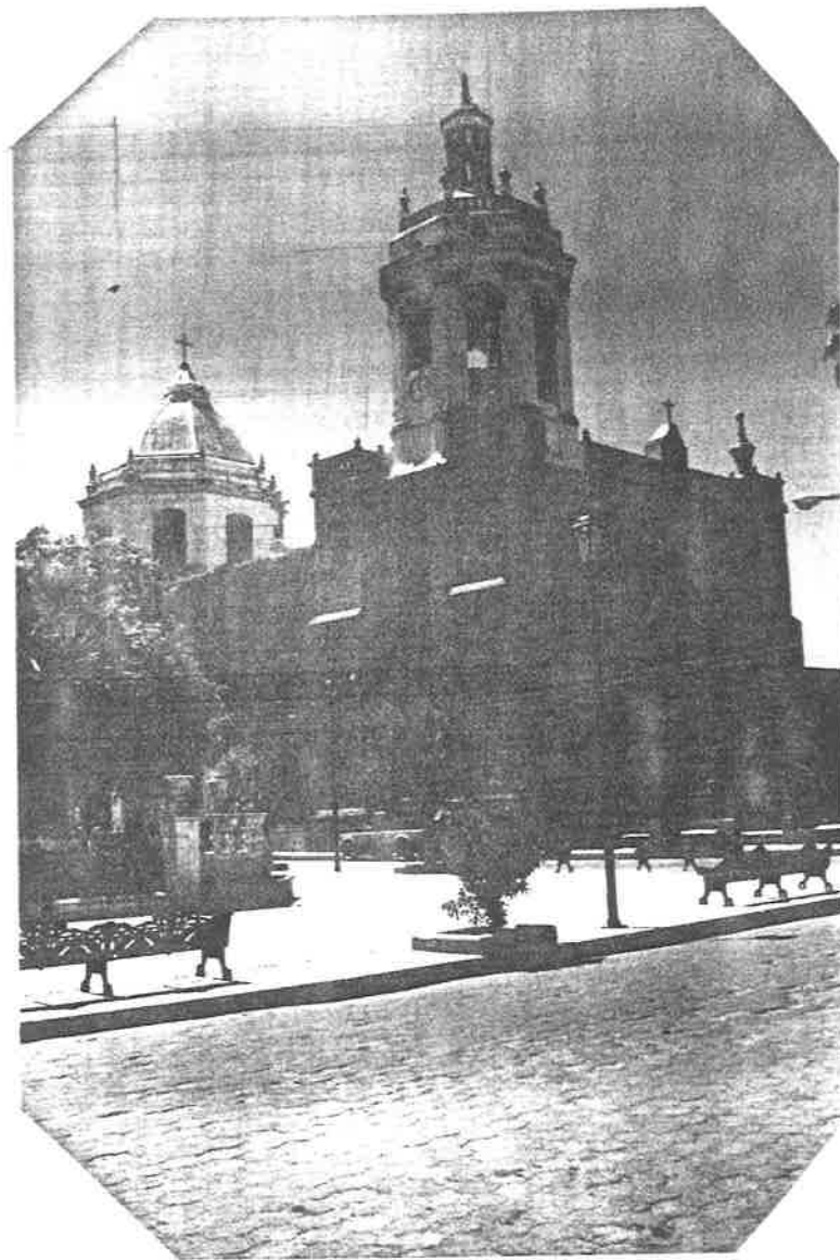
26.- Vista exterior de la parroquia de Guadalupe
