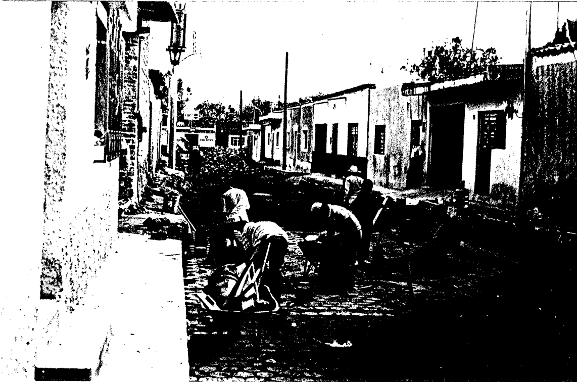
Obra en proceso
