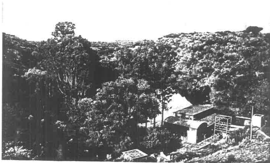
6.- Vista de la planta hidroeléctrica ubicada en la presa Miguel Alemán.
